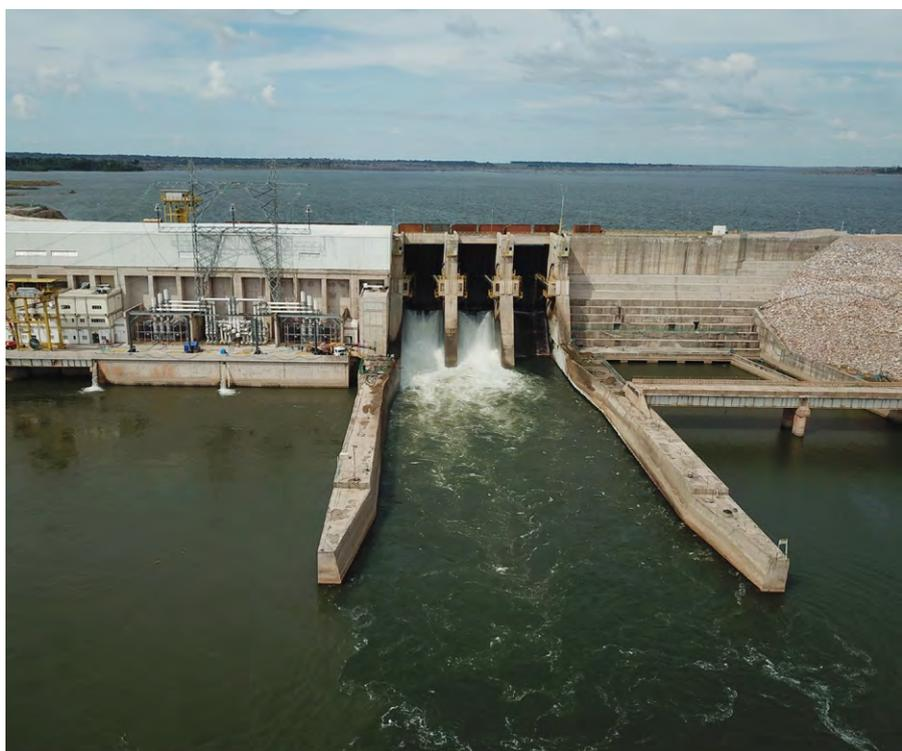
As duas turbinas Kaplan da planta, que conta com capacidade instalada de 401,88 MW, são responsáveis por uma vazão sanitária de 272 m<sup>3</sup>/s, gerando aproximadamente 50% de toda a energia consumida no estado do Mato Grosso e atendendo 1,6 milhão de pessoas.
