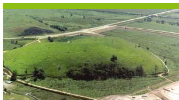
A construção da usina de 2001 até hoje
