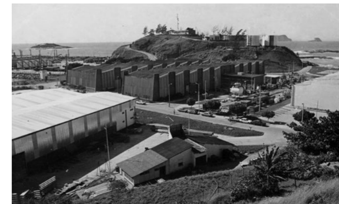
| Construção do Atual Terminal Alfandegado de Imbetiba, da Petrobras. Fonte: Biblioteca do IBGE
