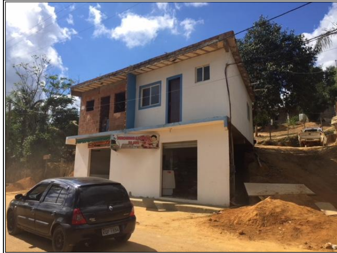
C30 – MERCADINHO E AÇOGUE DO JAPA – RESIDÊNCIA NO SEGUNDO PAVIMENTO, NA ESTRADA J. A. GORDIANO SIMAS
