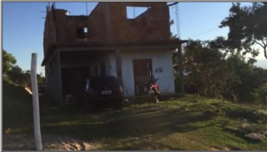
C33 – CASA EM CONSTRUÇÃO EM VIA SECUNDÁRIA
