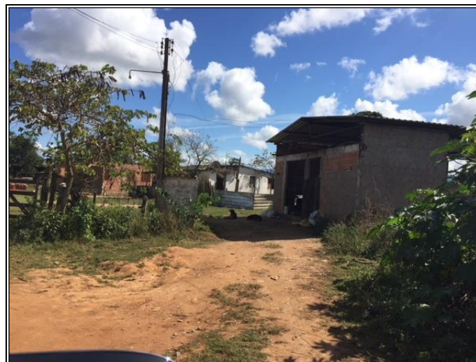
C47 – GALPÃO E CASA DE COLONO
