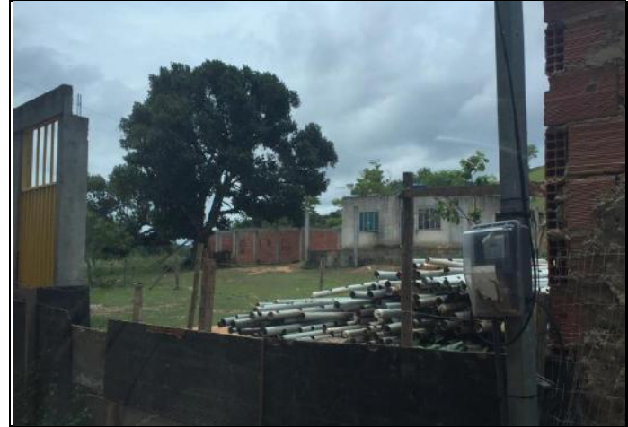
PRIMEIRO PLANO, MURO E GARAGEM DE C36, EM CONSTRUÇÃO. AO FUNDO, C36A - HABITAÇÃO (REVESTIMENTO BRANCO). MAIS AO FUNDO, JUNTO À ÁRVORE, C36B – CASA EM CONSTRUÇÃO.
