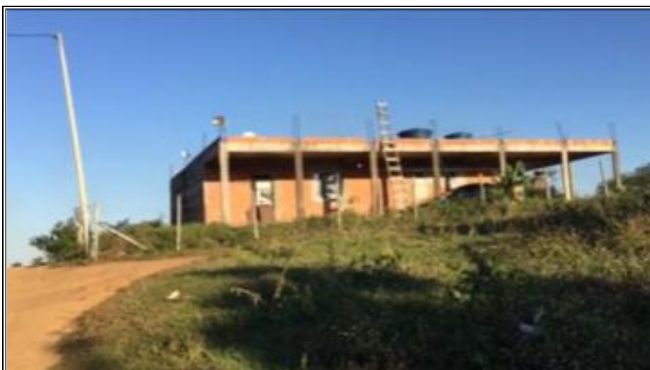
C32 – CASA EM CONSTRUÇÃO EM VIA SECUNDÁRIA
