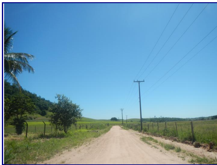
Foto 7.4.4-9: REDE DE DISTRIBUIÇÃO DE ENERGIA ELÉTRICA FONTE: ECOLOGUS, 2018.
