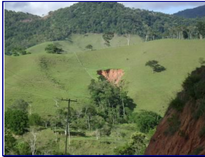
Foto 7.2.1-3: VOÇOROCA ENCONTRADA NUMA VERTENTE NA BACIA DO RIO MACAÉ. FONTE: SILVA, F. G. (2010)
