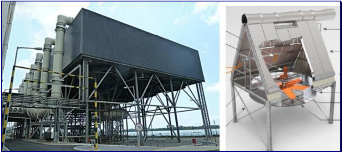
**FIGURA 3.5.8-1:** CONDENSADOR REFRIGERADO A AR
