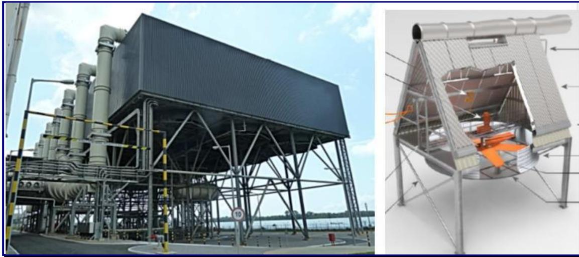
**FIGURA 3.4.3-9:** IMAGENS DE UM CONDENSADOR REFRIGERADO A AR
